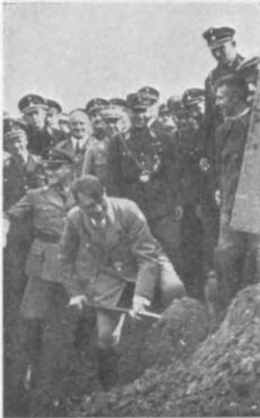
108. Eröffnung des Autobahnbaues durch den Führer
