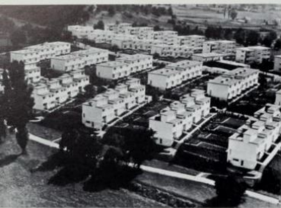
445. M. E. Haefeli, C. Halbacher, R. Steiger, P. Artaria, W. M. Moser, E. Roth, and H. Schmidt, aerial view, Neubühl Werkbandsiedlung, Zurich, 1929-32
